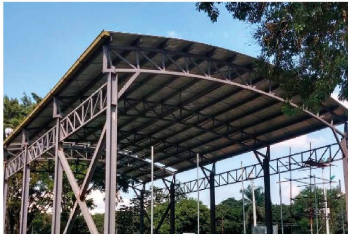
La teja sin traslazo STANDING SEAM es una teja metálica ideal para cubiertas y cerramientos sin traslazos, através de un sistema compuesto de bandejas de acero interconectadas mediante uniones grafadas y ganchos ocultos de fijación que no perforan el material.
